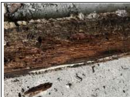
Photo n° PhTer001 Localisation : Extérieur - Abris de jardin Ouvrage : Mur - Bois Parasite : Présence d'indices d'infestation de termites Indices : altérations dans le bois, bois d'apparence feuilleté
