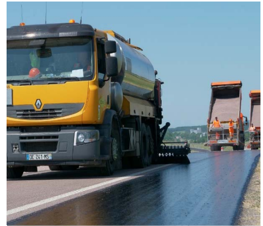
Gravillonnage superficiel Source : Vosges.mag
