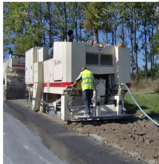
Traitement en place Source : Infociment
