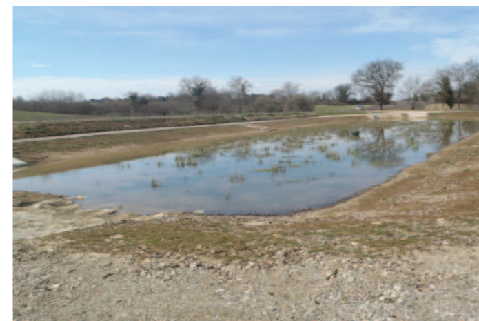
Après travaux : un bassin paysager en cours de colonisation végétale
