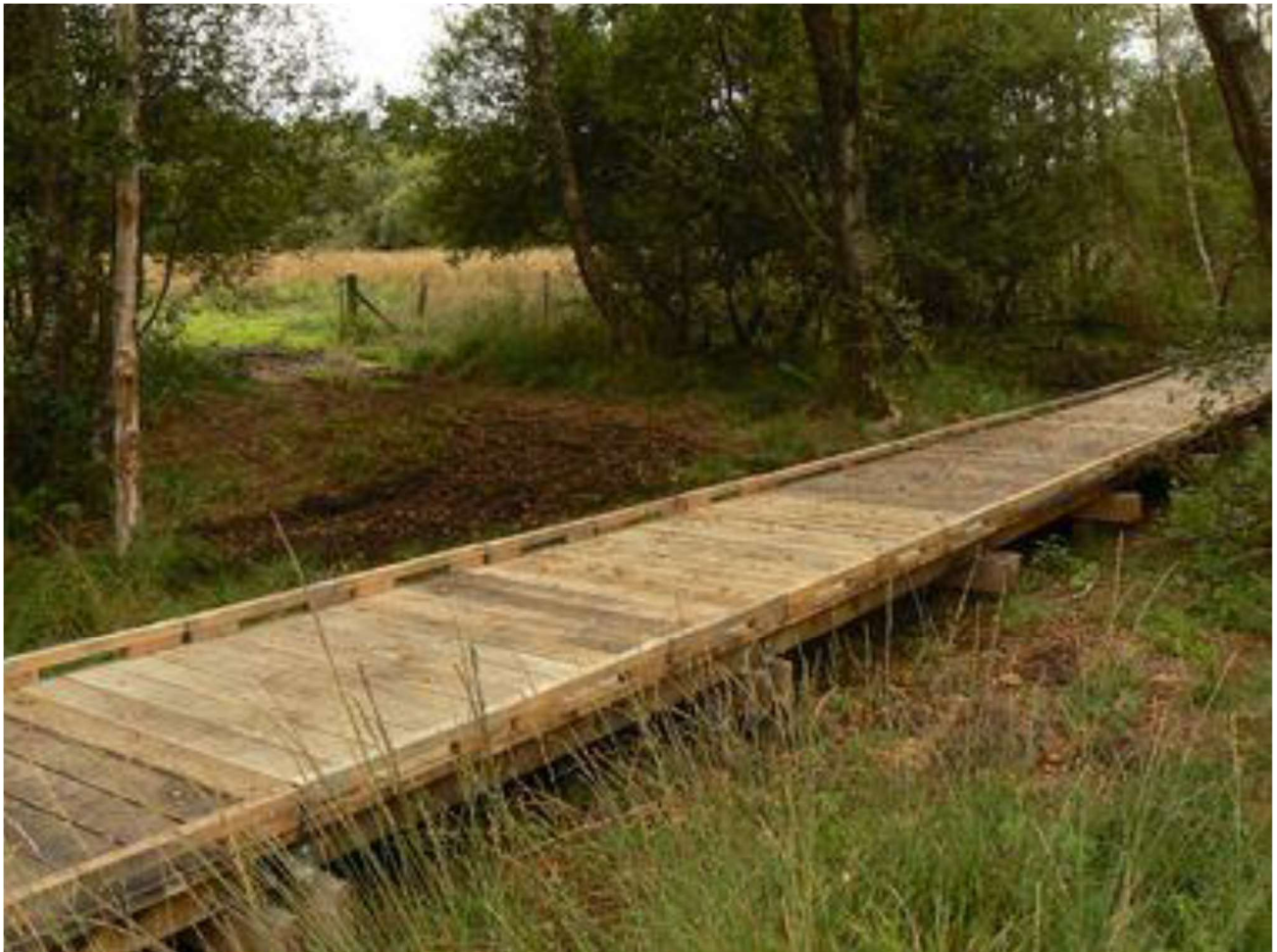
Exemple de platelage bois avec chasse-roue implanté en prairie
