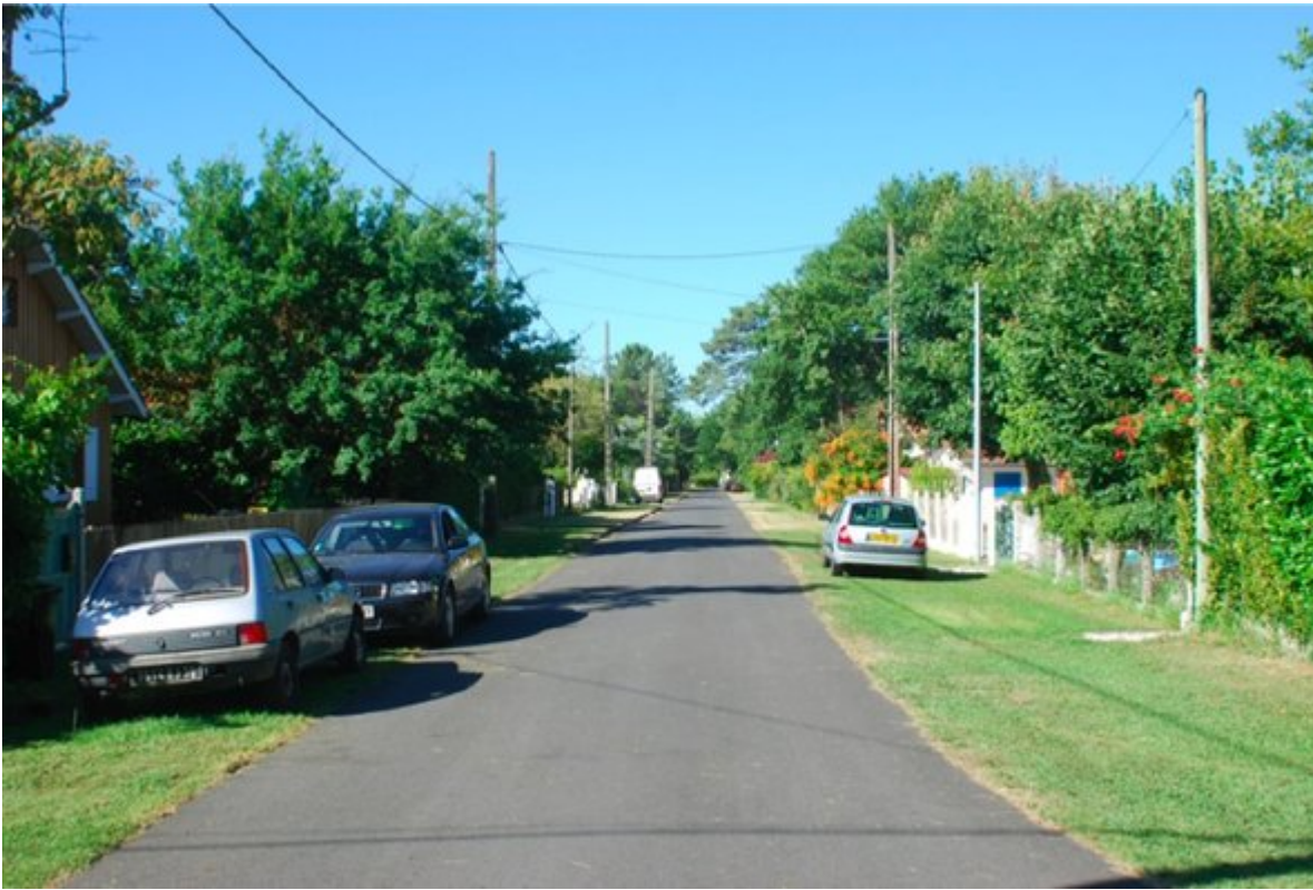
Un bon exemple d'espace public : voie minéralisée étroite, bandes enherbées d'accompagnement (Andernos) crédits : Agence Folléa-Gautier
