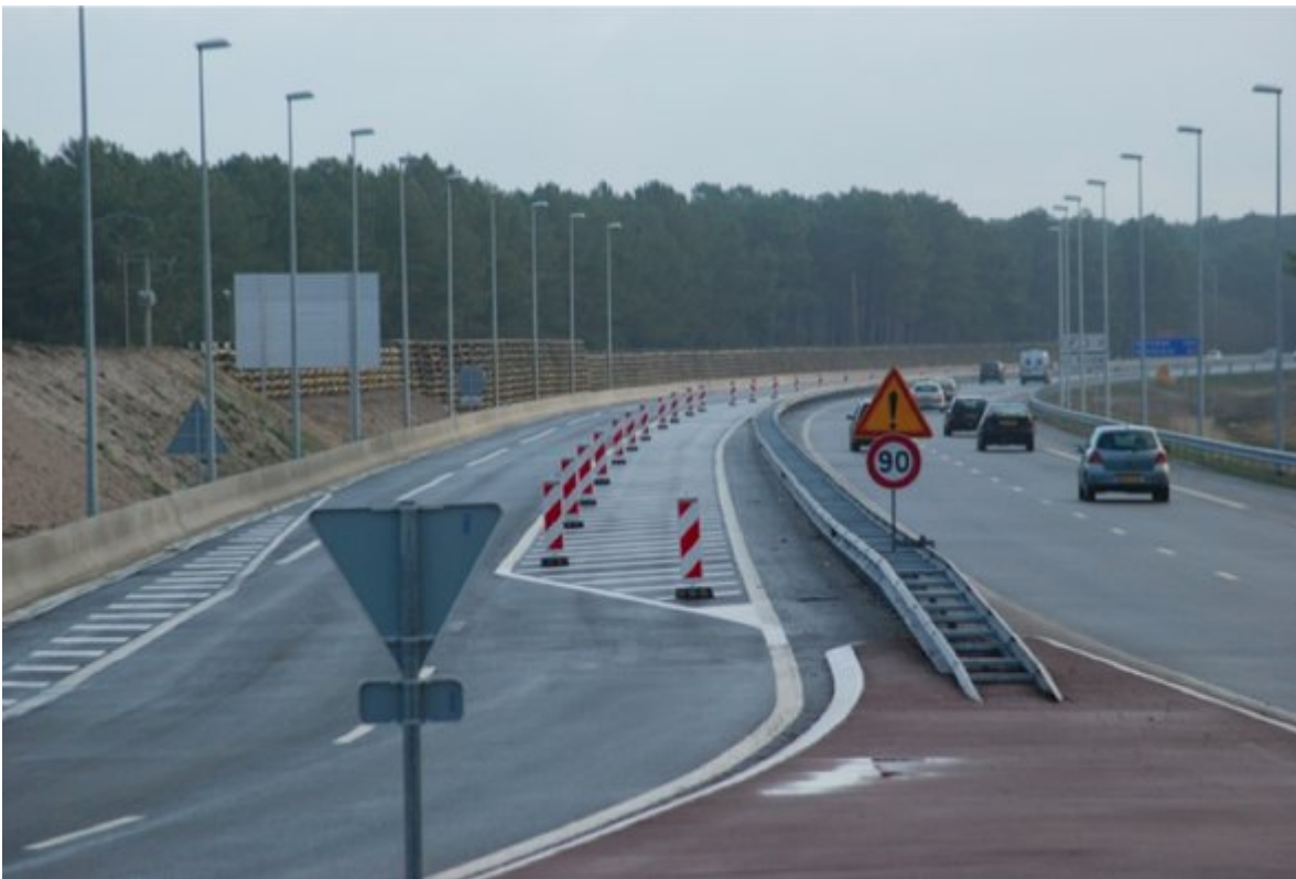
L'A660 (ici à Gujan-Mestras), aux aménagements routiers banalisants crédits : Agence Folléa-Gautier
