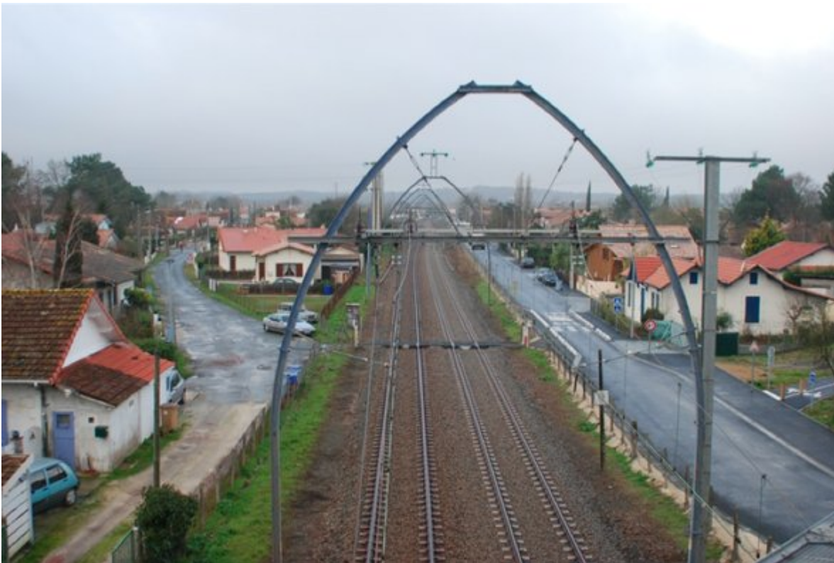
La voie ferrée : une coupure importante au cœur de l'urbanisation (ici à La Teste) crédits : Agence Folléa-Gautier
