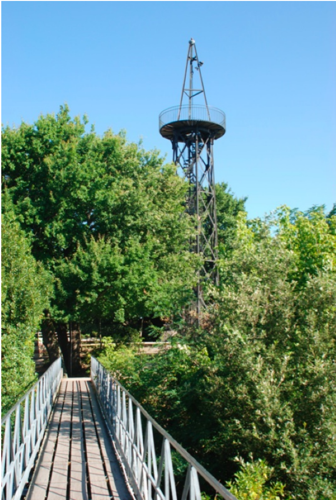
La passerelle Saint-Paul et l'observatoire Sainte-Cécile, construits en 1862 et 1863 crédits : Agence Folléa-Gautier
