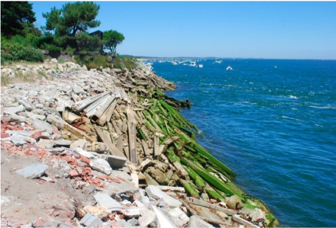
Protections contre l'érosion au Cap Ferret crédits : Agence Folléa-Gautier
