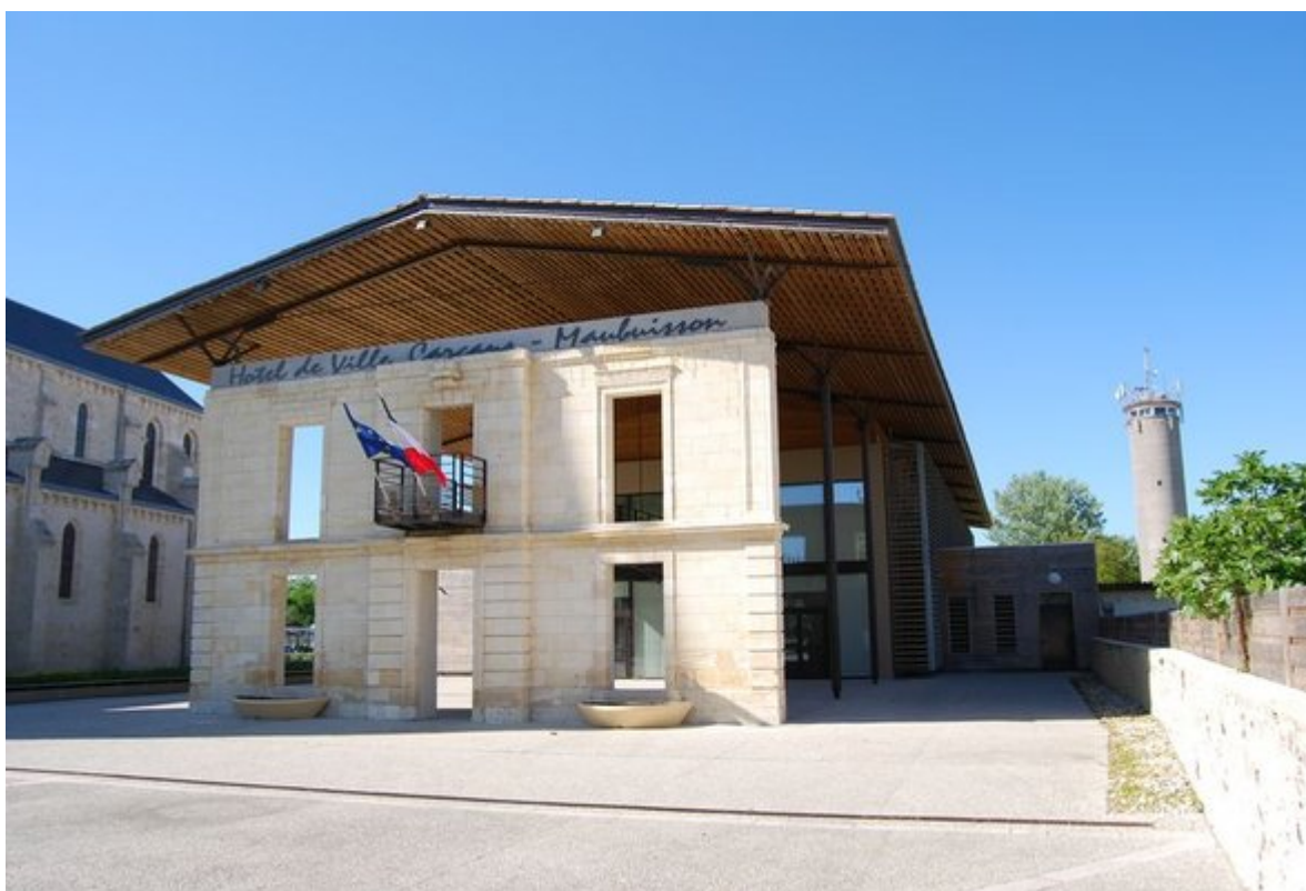
Bâtiment contemporain intégrant la façade d'origine - Mairie de Carcans crédits : Agence Folléa-Gautier
