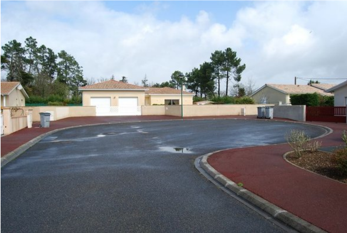
Implanté en bord de route, ce lotissement ne se tourne que sur lui-même, Pompignac crédits : Agence Folléa-Gautier
