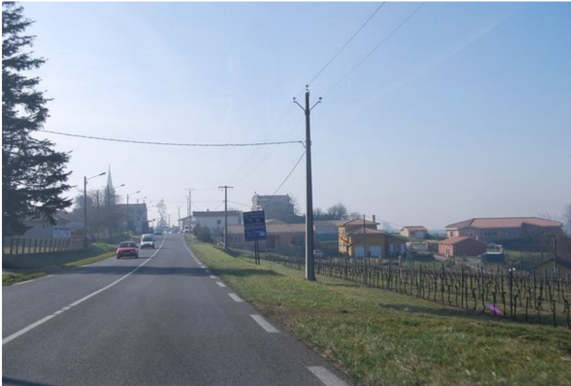
Entrée de village dévalorisée par une architecture banalisante - Le Pian-sur-Garonne crédits : Agence Folléa-Gautier
