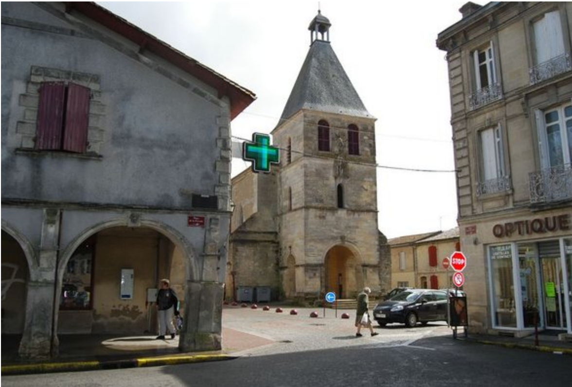
L'église de Créon, située au sud de la place en suivant la diagonale crédits : Agence Folléa-Gautier
