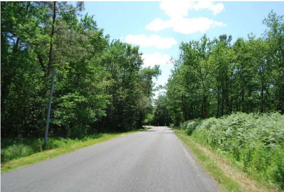
Franchissement de la ripisylve du ruisseau de Mérigot - Tizac-de-Lapouyade crédits : Agence Folléa-Gautier
