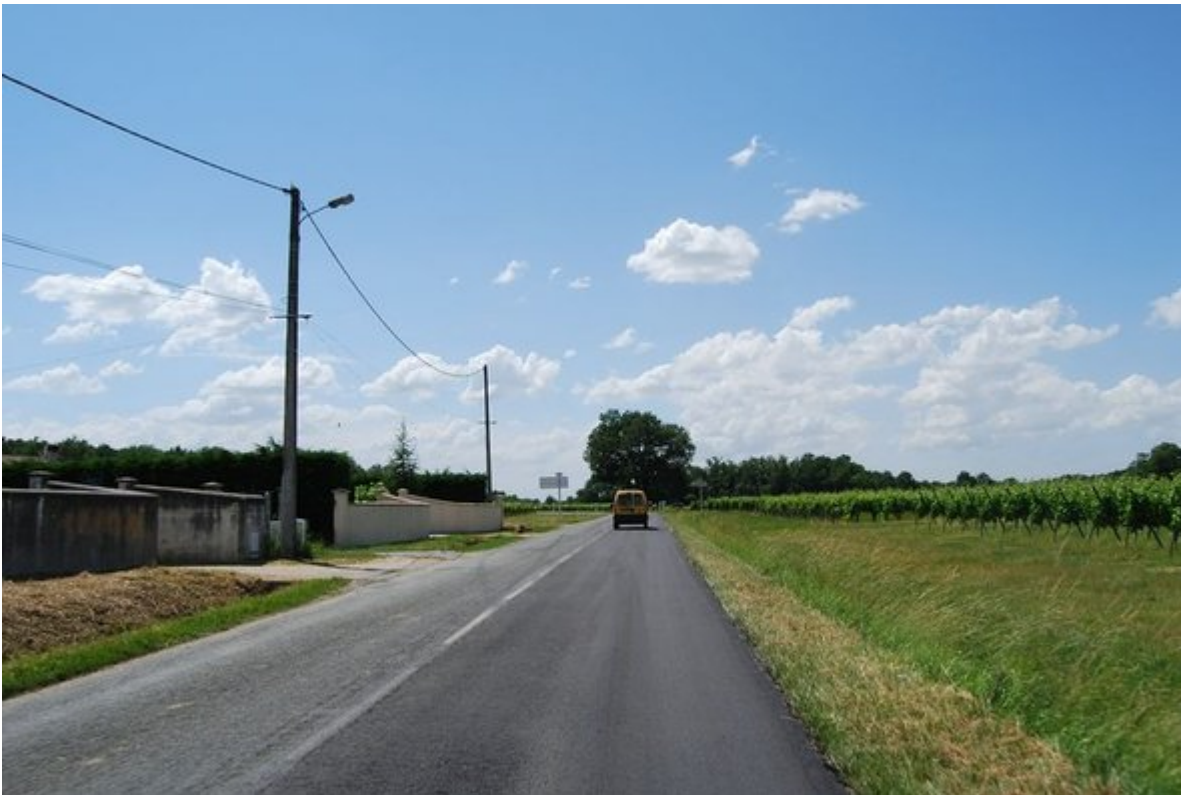
Talus et fossé enherbé accompagnent la route à droite, au long des vignes (à gauche, haies et clôtures banalisantes) - Civrac-de-Blaye crédits : Agence Folléa-Gautier
