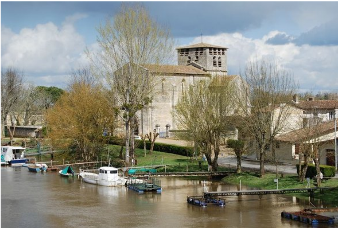
La qualité des berges n'est pas mise en valeur par la vétusté de certains pontons - Saint-Denis-de-Pile crédits : Agence Folléa-Gautier
