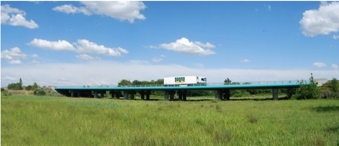
Le passage en viaduc de l'autoroute A89 a permis de préserver des zones humides - Saillans crédits : Agence Folléa-Gautier
