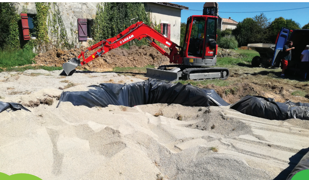
Travaux d'assainissement non collectif chez un particulier
