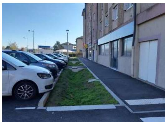
Après avoir étudié une solution classique de mise en séparatif des réseaux sur le projet de requalification, le maître d'ouvrage du projet soutenu par l'Agence de l'Eau, a ainsi envisagé la désimperméabilisation d'une partie du site et une gestion alternative des eaux pluviales reposant sur :
