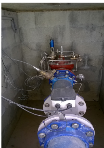
Vanne modulation pression secteur SO1, SIAEP du Blayais
