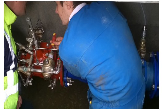
Réglage vanne modulation secteur N2
