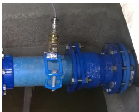
Point de mesure de pression, SIAEP du Blayais
