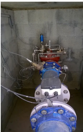
Équipements modulation pression
