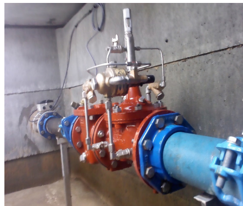
Vanne modulation pression, SIAEP du Blayais
