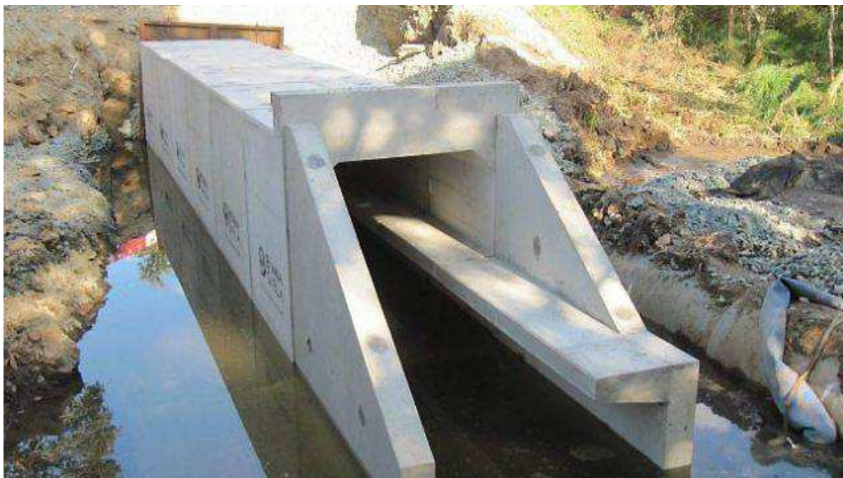
Eléments préfabriqués comportant une banquette qui permet le passage de la petite faune.
