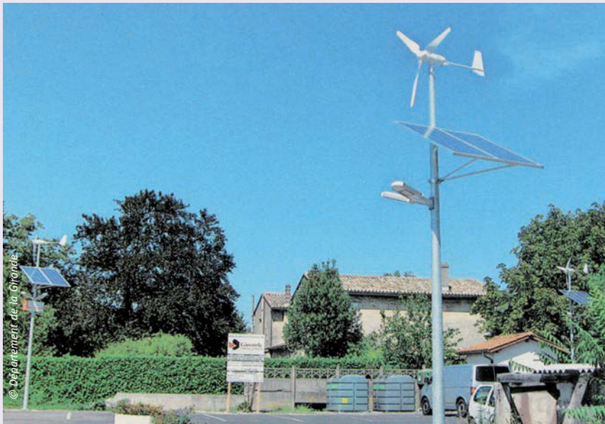
Éclairage public équipé d'une source autonome : éolienne et photovoltaïque
