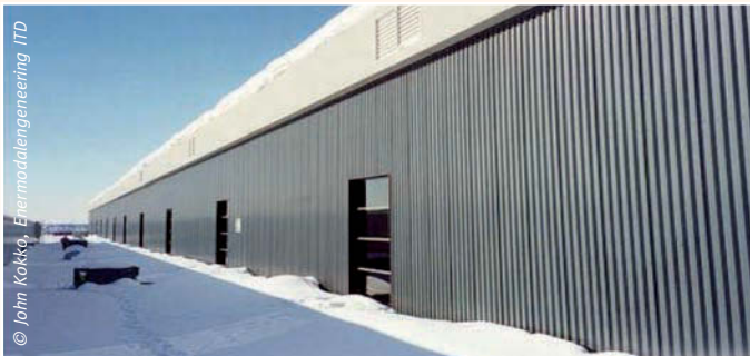
Système de chauffage solaire de l'air de l'usine Canadair (Canada)
