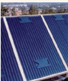
Système de chauffage solaire de l'air de l'usine Canadair (Canada)
