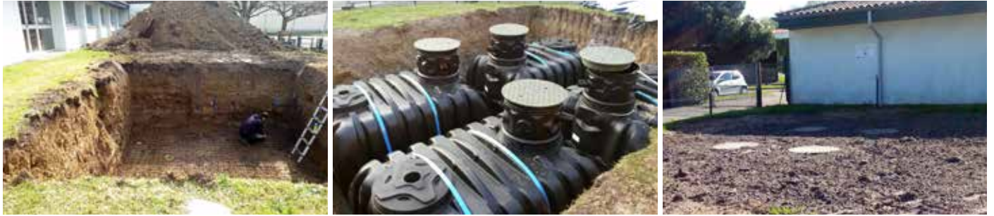
Photos de l'installation de 4 cuves enterrées pour une capacité totale de 20m³ sur le terrain de l'école de la commune de Salleboeuf. Pictures of the installation of 4 underground tanks for a total capacity of 20m³ on the school grounds of Salleboeuf municipality.
