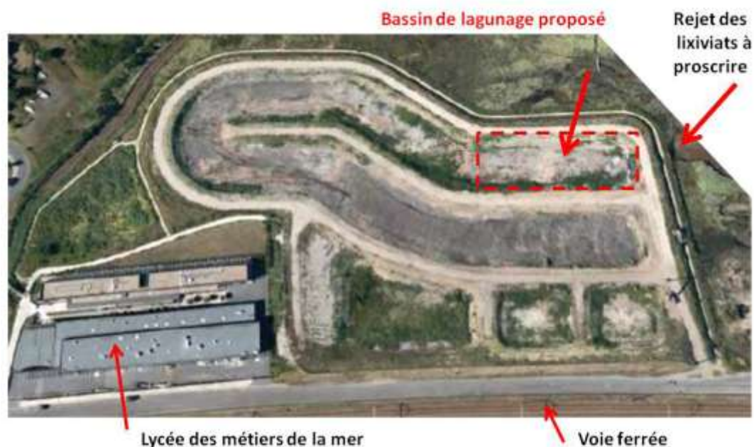
Bassin de décantation de La Molle
