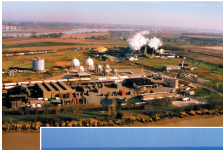
Site COBOGAL à AMBÈS
